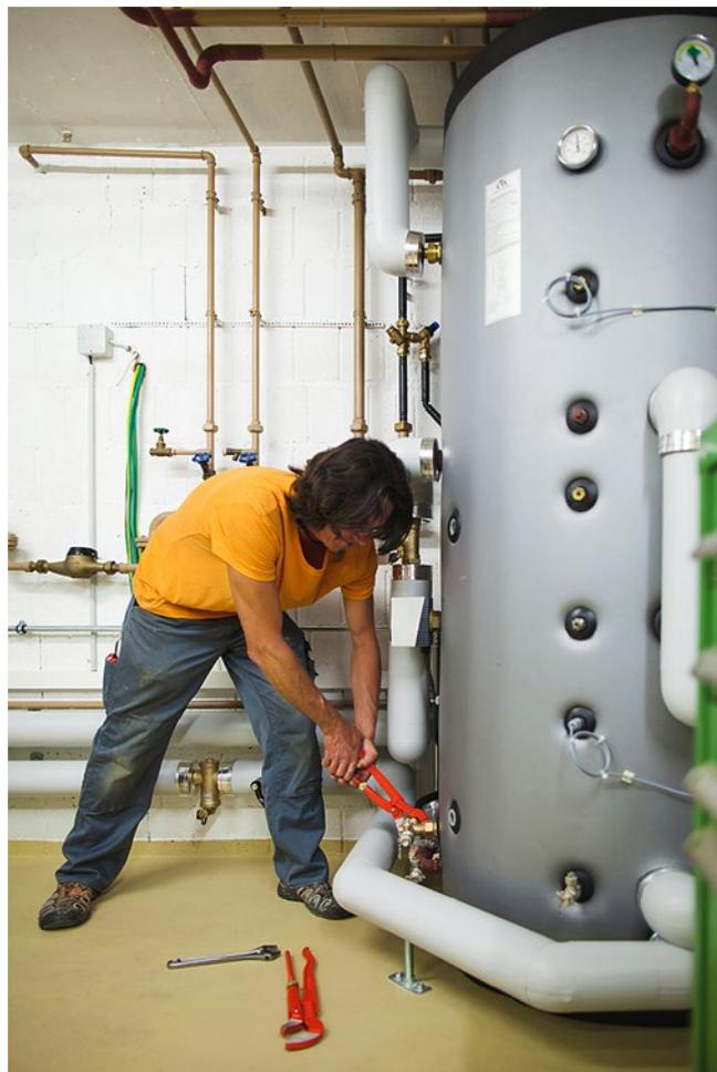
[FIG. 4] Contrôle et essai d'étanchéité sur l'accumulateur.
